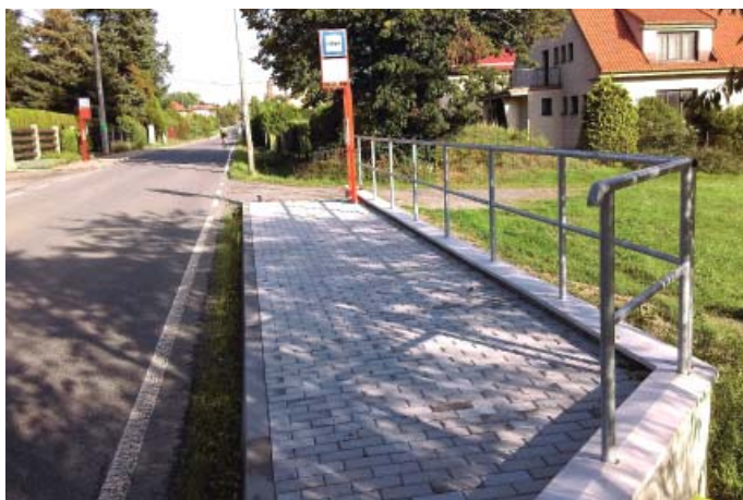
Nové zastávky v ulici Hlavní
