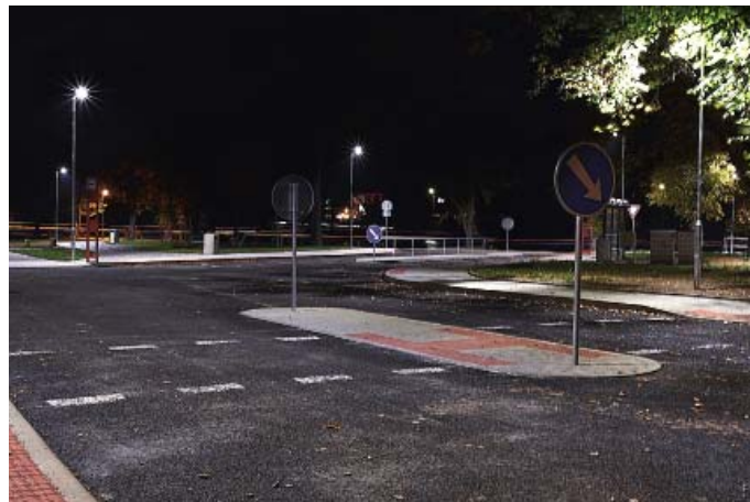
Nové zastávky na návsi – dokončení
